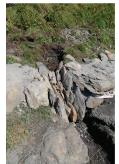
Renvoi d'eau pour éviter un creusement du sentier
