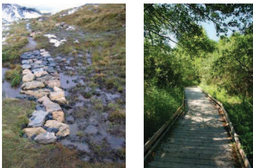
Exemple de platelage et de dallage installés pour limiter la détérioration du milieu naturel
